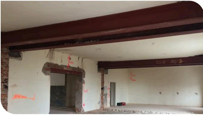
Im großen Festsaal mussten tragende Innenwände entfernt und die Decke mit Stahlträgern gesichert werden. Quelle: PORR
