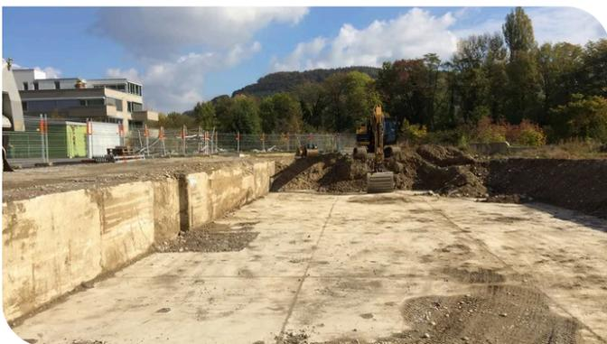
Die trockene Baugrube mit alten Gebäudestrukturen, die belassen wurden. Das neue Untergeschoss wurde in die alte Struktur hineingebaut und zur Weißen Wanne abgedichtet. Quelle: PORR AG
