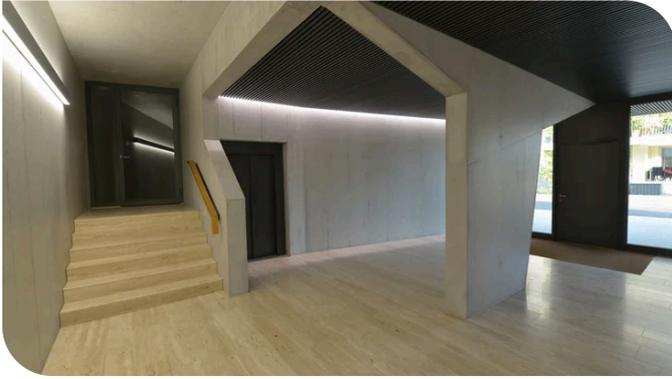
Die fertige Eingangshalle mit der markanten Betonstütze: Mittels Rückbiegeanschluss war ein unsichtbarer Anschluss der Decke möglich. Quelle: PORR AG
