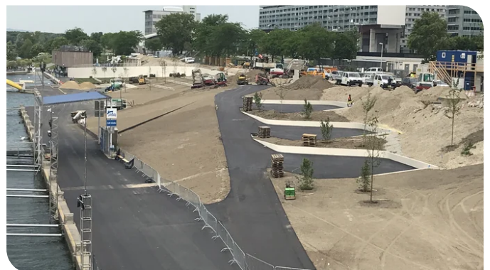
Im Böschungsbereich errichtete die PORR mehrere unregelmäßig gekrümmte Stützmauern. Die größte Stützmauer beginnt am Kai und läuft an der Böschungsoberkante aus (Bildhintergrund). Quelle: PORR
