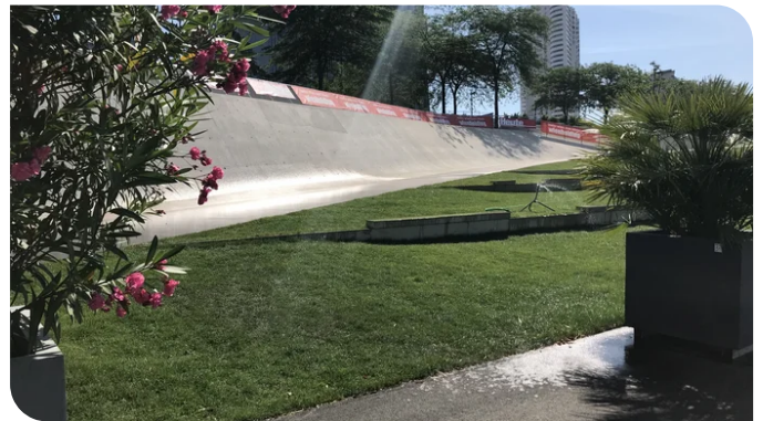
Die geraden Stützmauern aus Betonfertigteilen laden mit Sitzmöglichkeiten zum Verweilen ein. Quelle: PORR
