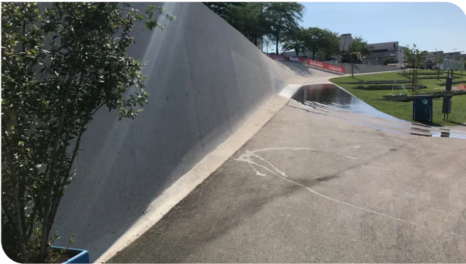
Die Sichtbetonflächen mussten mit Sonderschalungen angefertigt werden. Quelle: PORR
