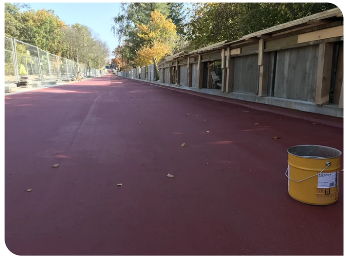
Der Brückenfahrbahnbelag wurde ebenso wie die historischen Betongeländer ausgetauscht. Quelle: PORR
