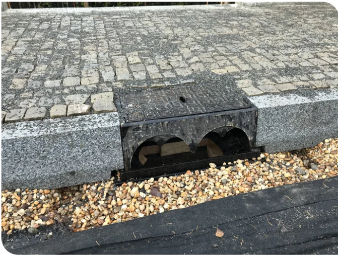
Selbst die Bordsteinentwässerung musste den Vorgaben der Denkmalschutzbehörde entsprechen. Quelle: PORR
