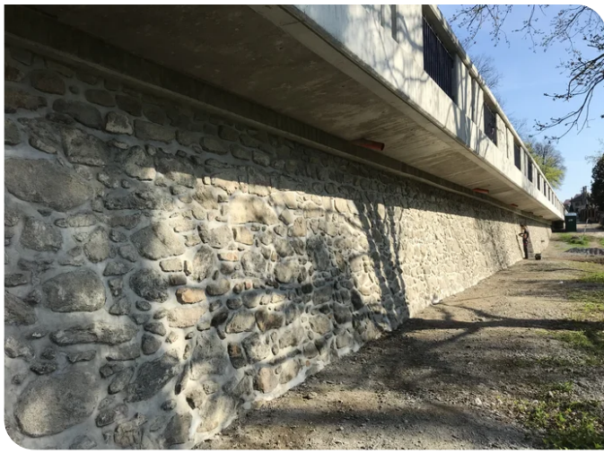
Das Fundament der Brücke besteht aus Natursteinen. Quelle: PORR
