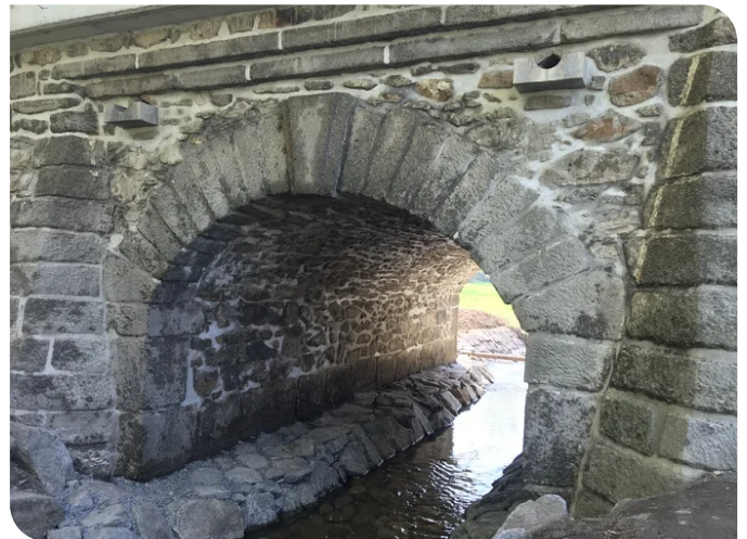
Die Fugensichtflächen wurden weder geglättet noch anderweitig bearbeitet. Fehlendes Natursteinmauerwerk wurde mit Bruchstein ergänzt. Quelle: PORR
