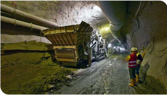
Das Ausbruchsmaterial des Sprengvortriebs wurde vor Ort von einem Becher aufbereitet und mit einer Förderbandanlage abtransportiert. Quelle: Toni Rappersberger
