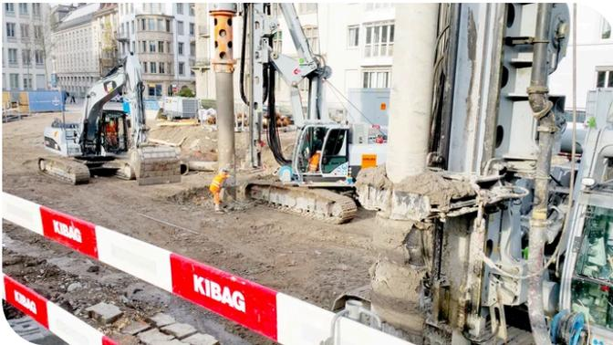
Gründungsarbeiten bis in 17 m Tiefe: Da das Baufeld im Bereich einer nicht tragfähigen Seeablagerung liegt, entschied sich die Bauherrin gegen eine umfassende Sanierung und für einen Ersatzneubau.
