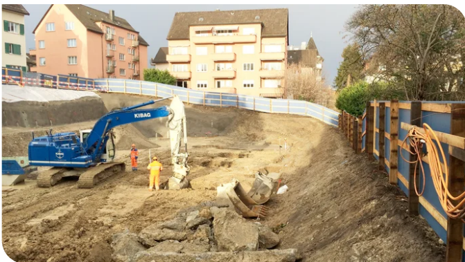
Die Baugrube nach Abriss der größten Neuapostolischen Kirche der Schweiz. Bild: PORR AG
