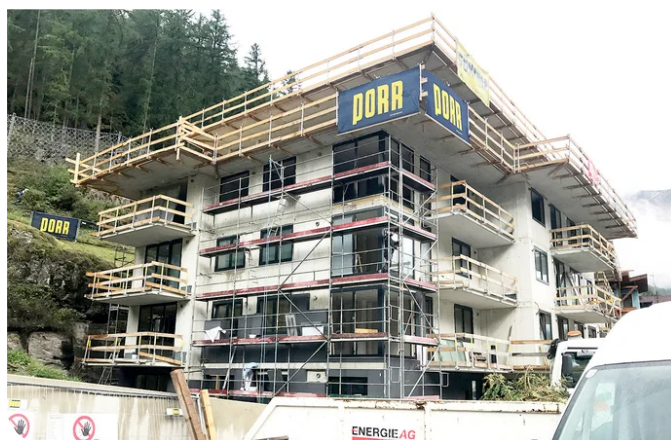
Alle tragenden Wände und Decken des Apartmenthauses wurden in Stahlbeton errichtet. Bild: PORR AG
