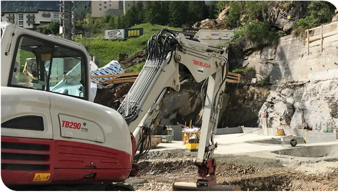
Die Baugrube wurde mit Spritzbeton gesichert. Bild: PORR AG
