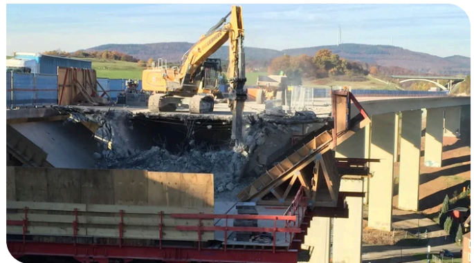
Die Abbrucharbeiten erfolgten mittels Bagger. Bild: PORR AG
