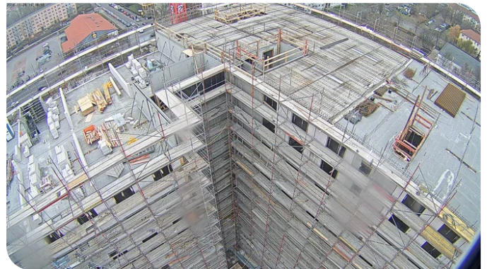
Das Tragwerk des Studentenwohnheims wurde in Schottenbauweise errichtet. Bild: PORR AG
