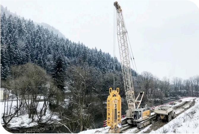
Die Dichtwand wurde großteils als Einphasen-Dichtschlitzwand mit 60 cm und 80 cm Wandstärke, teils auch als Düsenstrahl-Dichtwand hergestellt. Die maximale Tiefe der Schlitzwand liegt bei 33,0 m. Im Mittel beträgt die Schlitzwandtiefe 26 m. Eine besondere Herausforderung beim Bau der Schlitzwand waren die beengten Platzverhältnisse entlang der Gurk. Teilweise war die vorhandene Arbeitsfläche kaum breiter als das Fahrwerk des Seilbaggers.
