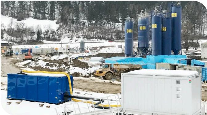
Bodenluftabsauganlage (blauer Container) mit provisorischer Abgasleitung während des Baustellenbetriebs. Bild: PORR Umwelttechnik GmbH
