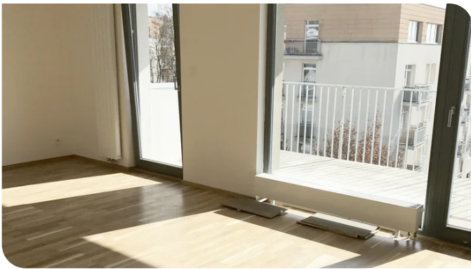
Wohnzimmer mit schwimmendem Fertigparkett aus Holz und Holzfenstern. Bild: PORR AG
