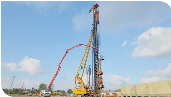
Betonieren des Simplex-Ortbetonrammpfahls. Bild: PORR
