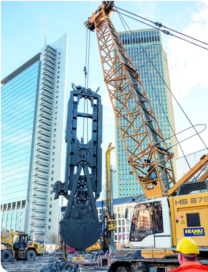
Schlitzwandgreifer vor Frankfurter Hochhauskulisse. Bild: FRANKI
