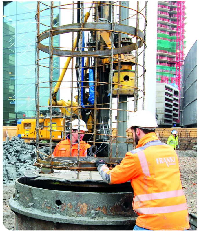
Druckmesskissen für den Fuß vor der Montage an den Bewehrungskorb. Bild: isg
