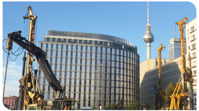
Großbohrgeräte bei der Erstellung von Bohrpfählen. Bild: PORR AG
