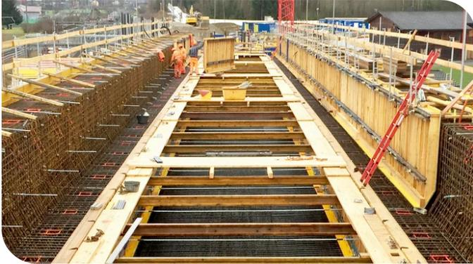
900 m<sup>3</sup> Konstruktionsbeton waren für die Errichtung einer Etappe der Bahnbrücke nötig. Bild: PORR AG
