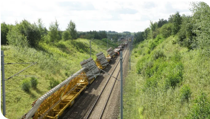
Transport der Weichenblocks. Bild: PORR AG
